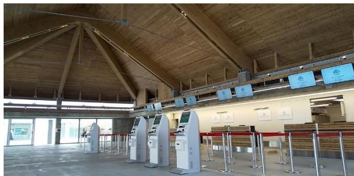
屋根構造材にCLT（直交集成板）を使用したチェックインロビー
