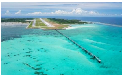
▲下地島空港 鳥瞰写真（北側より）
