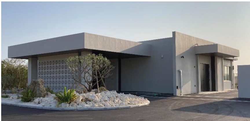
▲みやこ下地島空港ビジネスジェットターミナル
